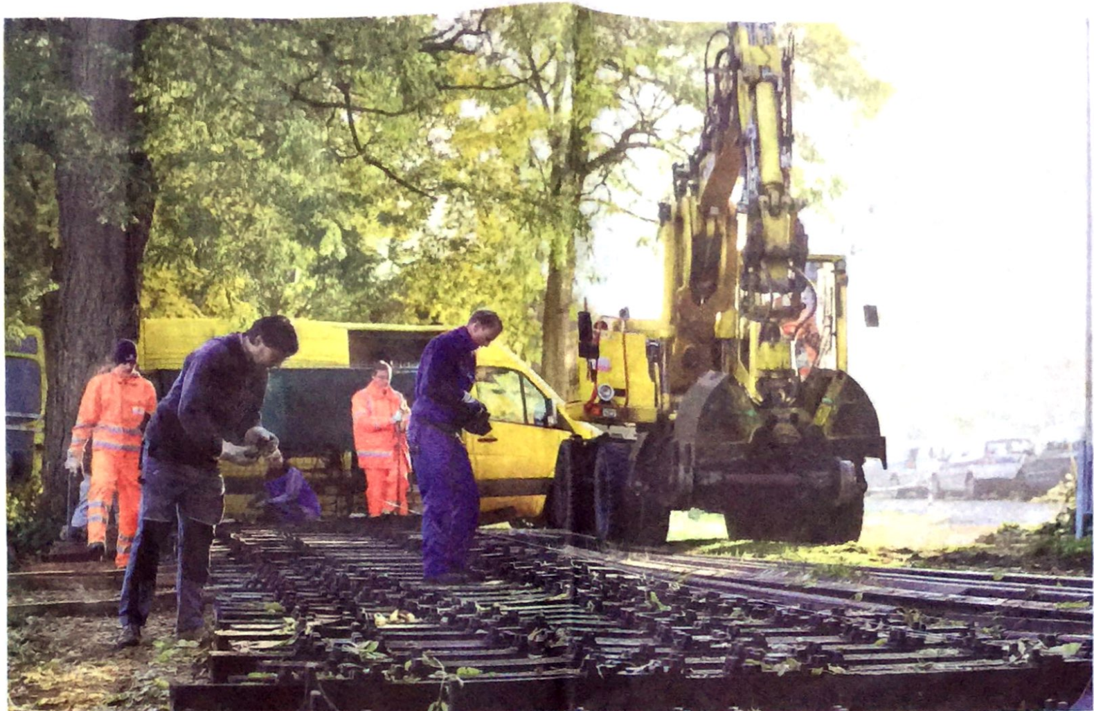
Der Zusammenbau der 30 Meter langen Weiche dauerte den ganzen Samstag. Die Weiche ist übrigens voll funktionstüchtig.
