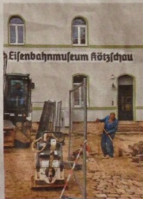
Pflasterarbeiten vor dem Haus
